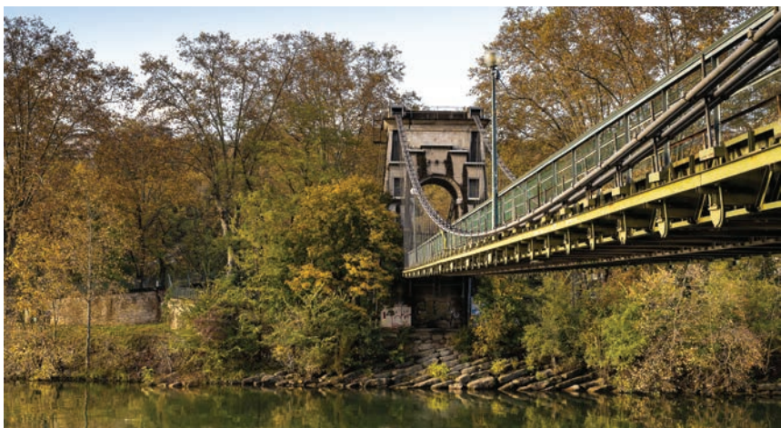
Le pont de l'Île Barbe, devenu passerelle en 2021.
